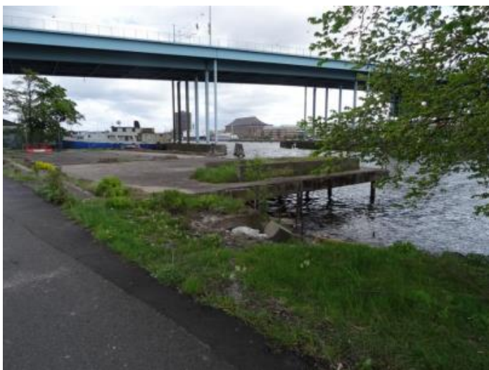
Foto: Betongdäck närmast Götaälvbron
